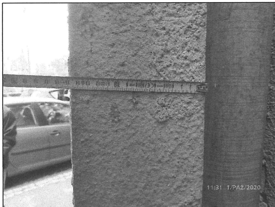
Fot. 5 Grubość ścianki obudowania rur spustowych
